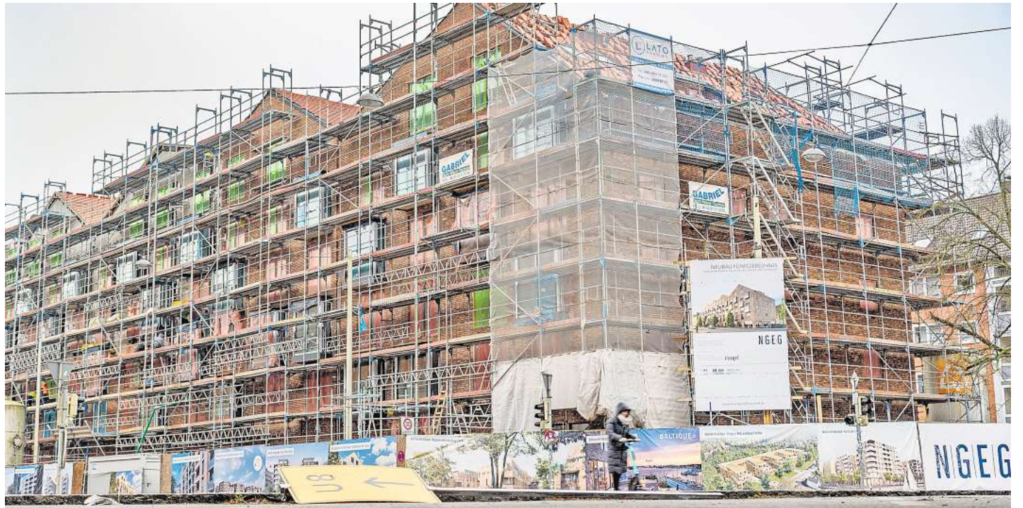
Baulich fast fertig ist das Fünfgiebelhaus zwischen Droyesen- und Waitzstraße in Kiel-Ravensberg. Noch nicht geklärt ist allerdings der Streit um einen möglichen Bio-Supermarkt im Erdgeschoss.
