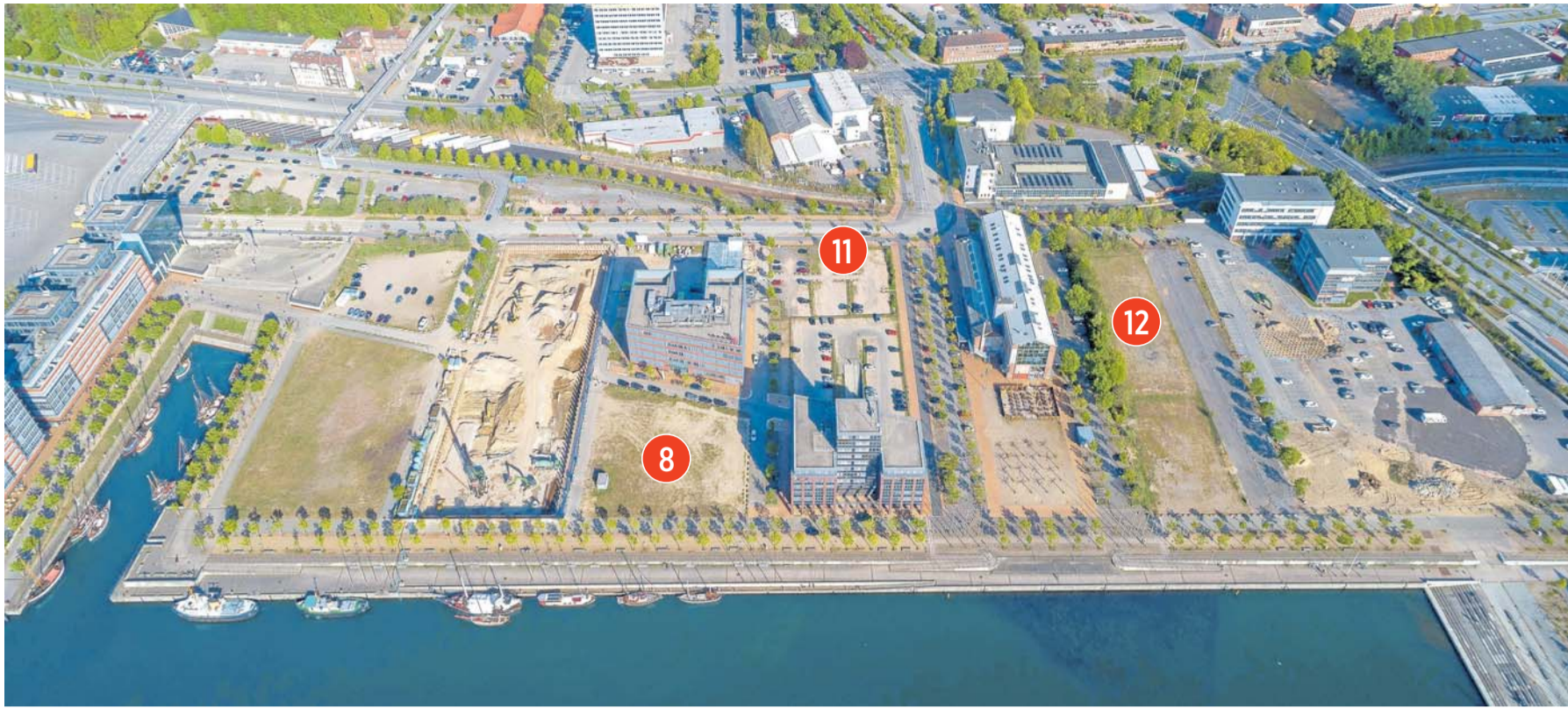
Auf den Baufeldern acht, elf und zwölf entstehen die neuen Gebäudekomplexe. Noch in diesem Jahr sollen die Bagger anrollen.
